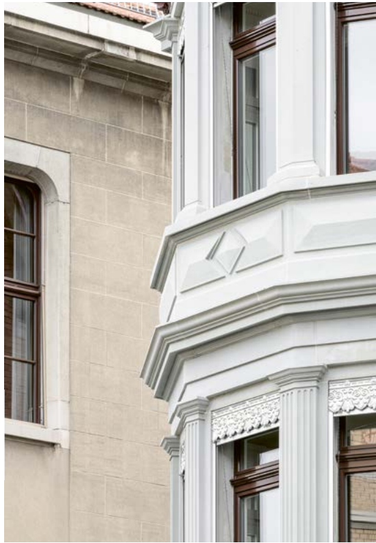
Der filigran ausgestaltete Erker wirkt nach den sorgfältigen Sandstein-Sanierungsarbeiten wieder lebendig und ausdrucksstark.
