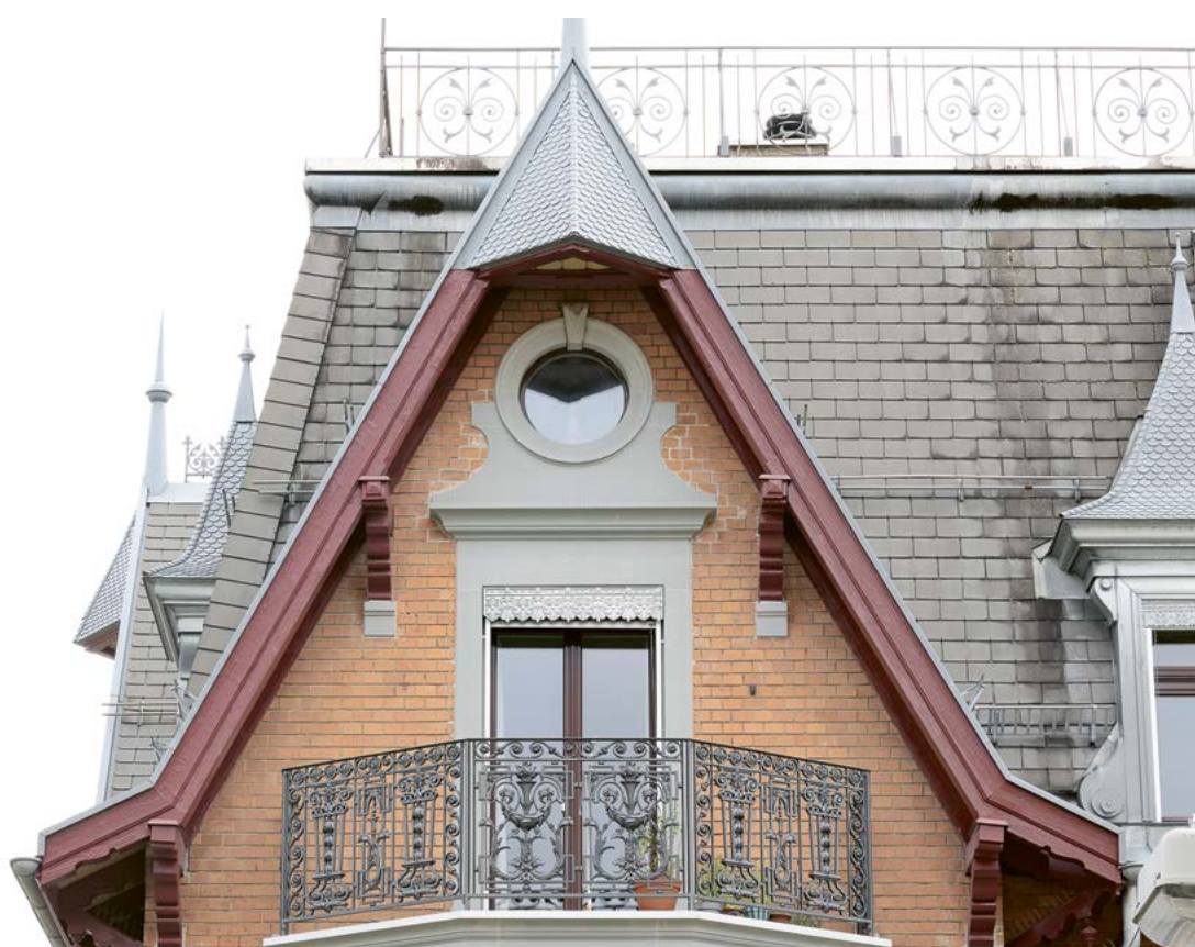
Selbst unter dem Dach – profilierte Sandstein-Elemente und ein reich verziertes Geländer.
