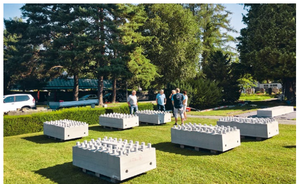
Die acht vorgefertigten Quader liegen zur Montage bereit.
